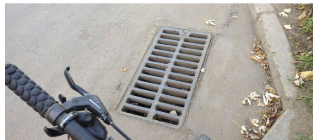
Приклад правильного облаштування дощоприймача (з горизонтальною решіткою). Фото з мережі Інтернет
