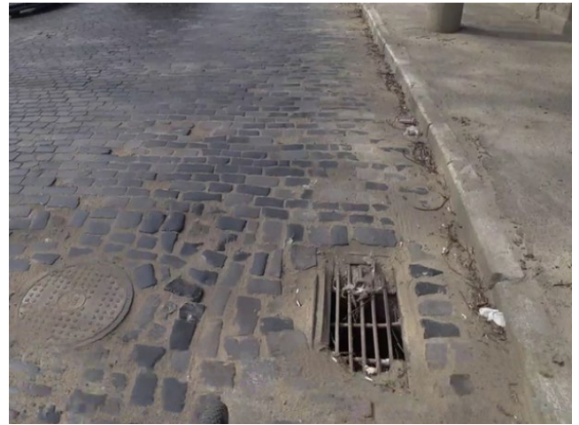
Приклад неправильного облаштування дощоприймача (з вертикальною решіткою)
