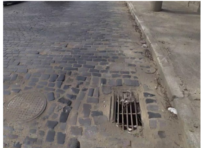
Приклад неправильного облаштування дощоприймача (з вертикальною решіткою)
